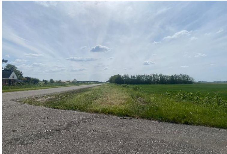
Figuur 16: De landbouwgrond klinkt in en ligt aanzienlijk lager dan de weg. (Bron: auteur)
